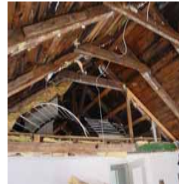
Beispiel: Zu sanierendes, teildämmtes Dach
