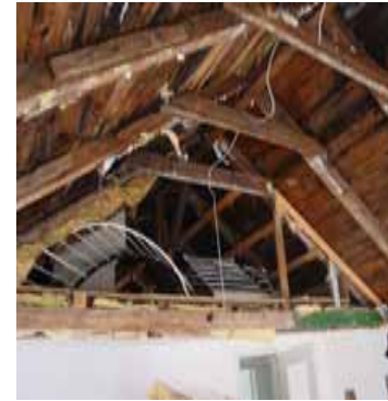
Beispiel: Zu sanierendes, teildämmtes Dach
